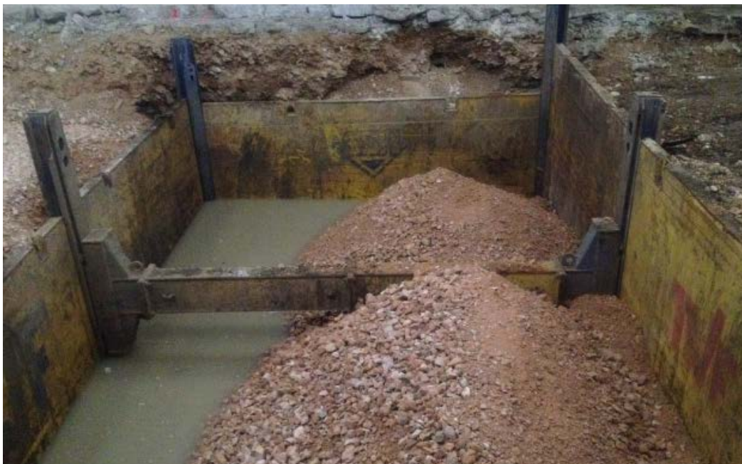
Photo 12. Fosse 2 : Remblaiement partiel avec matériaux GNT
