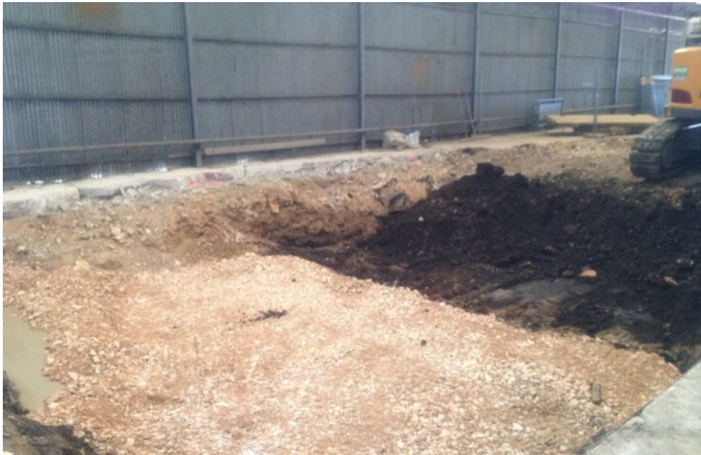
Photo 9. Excavation de la Fosse 2 : présence de remblais noirs (entre 1 et 2m)
