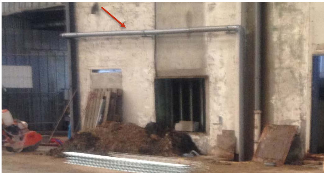
Photo 19. Dévoiement du réseau d'eau de ruissèlement de toiture
