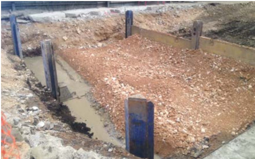
Photo 8. Fosse 1 : remblaiement partiel de la fosse avec des matériaux types GNT
