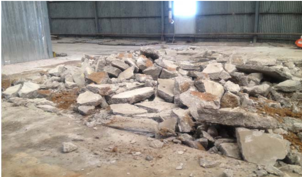
Photo 1. Découpage de la dalle béton avant la phase d'excavation
