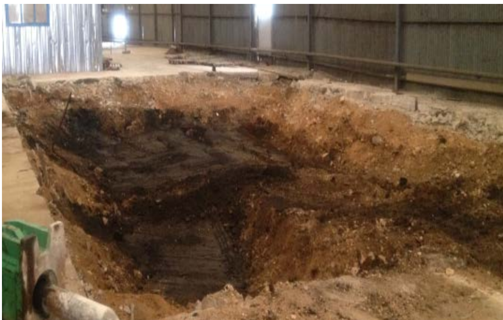
Photo 4. Excavation de la fosse 1: présence de remblais noirs (entre 1-2m de profondeur)
