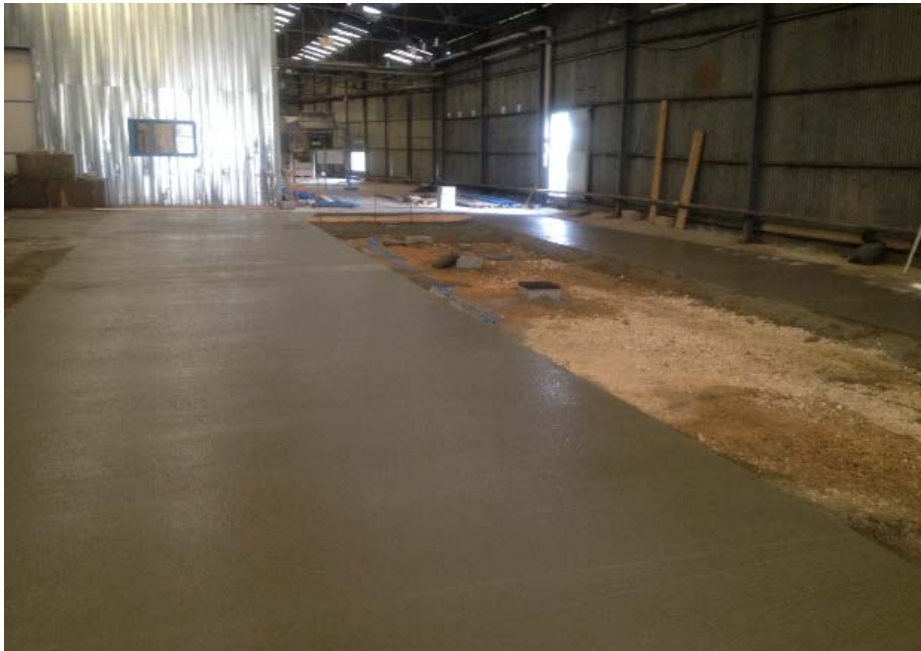
Photo 14. Réfection de la dalle béton au droit de la fouille
