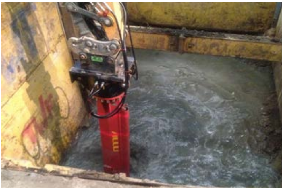
Photo 6. Fosse 1 : malaxage du fond de la fouille (Soil mixing)
