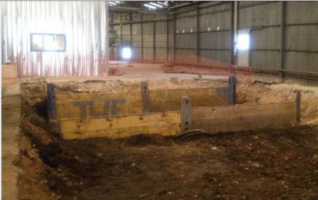
Photo 5. Excavation de la fosse 1: pose des palplanches (blindage)
