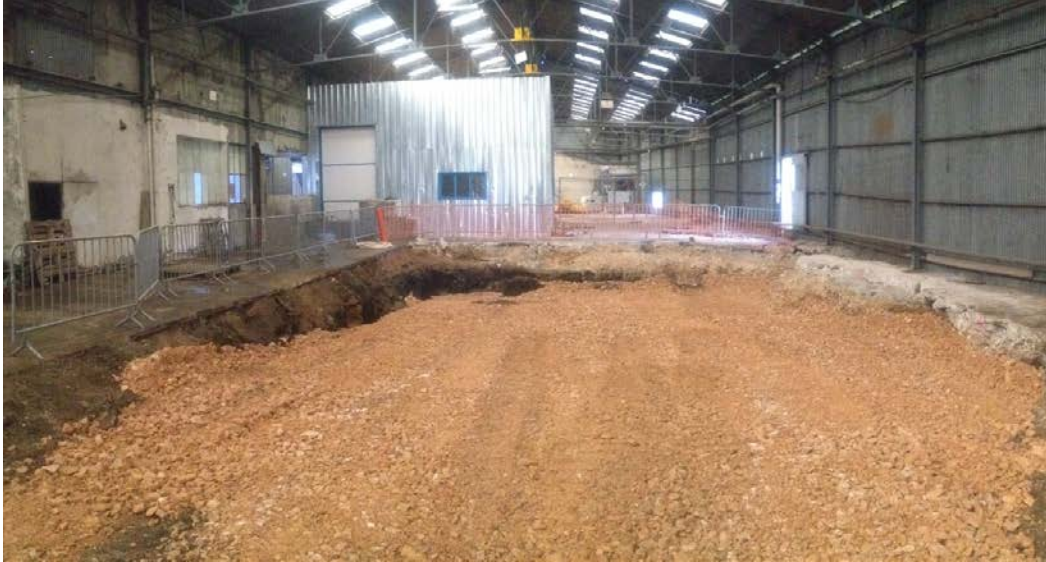
Photo 13. Fosse 1 et 2 : phase de compactage des matériaux
