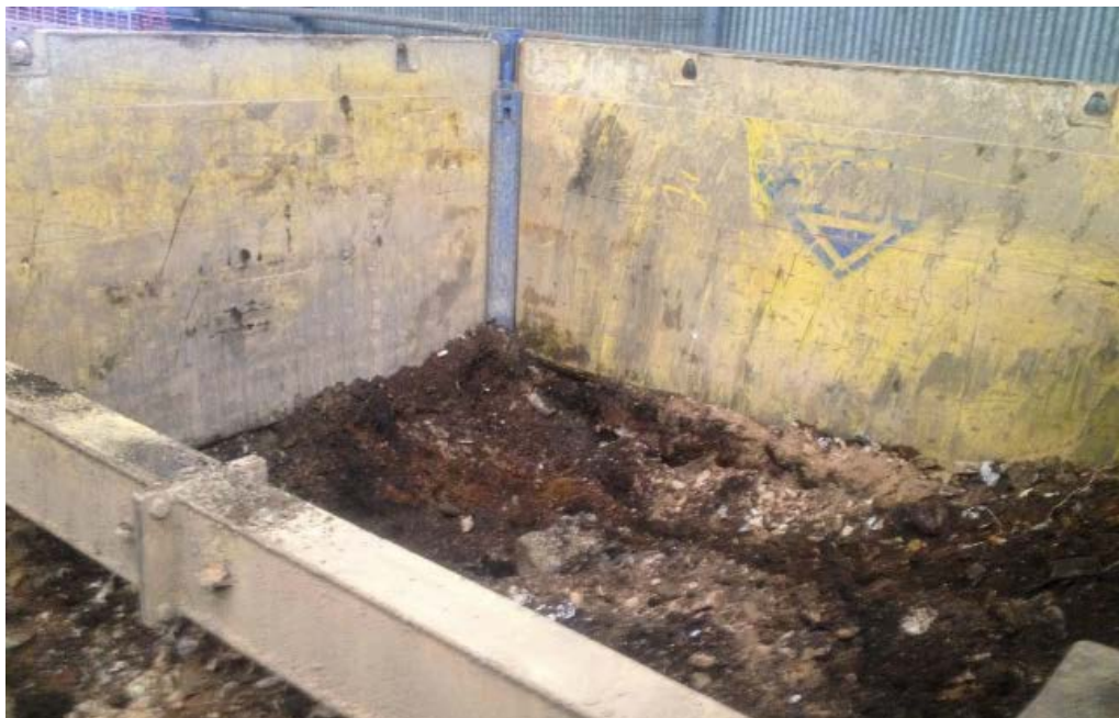
Photo 10. Fosse 2 : pose des palplanches et excavation entre 2 et 5 m
