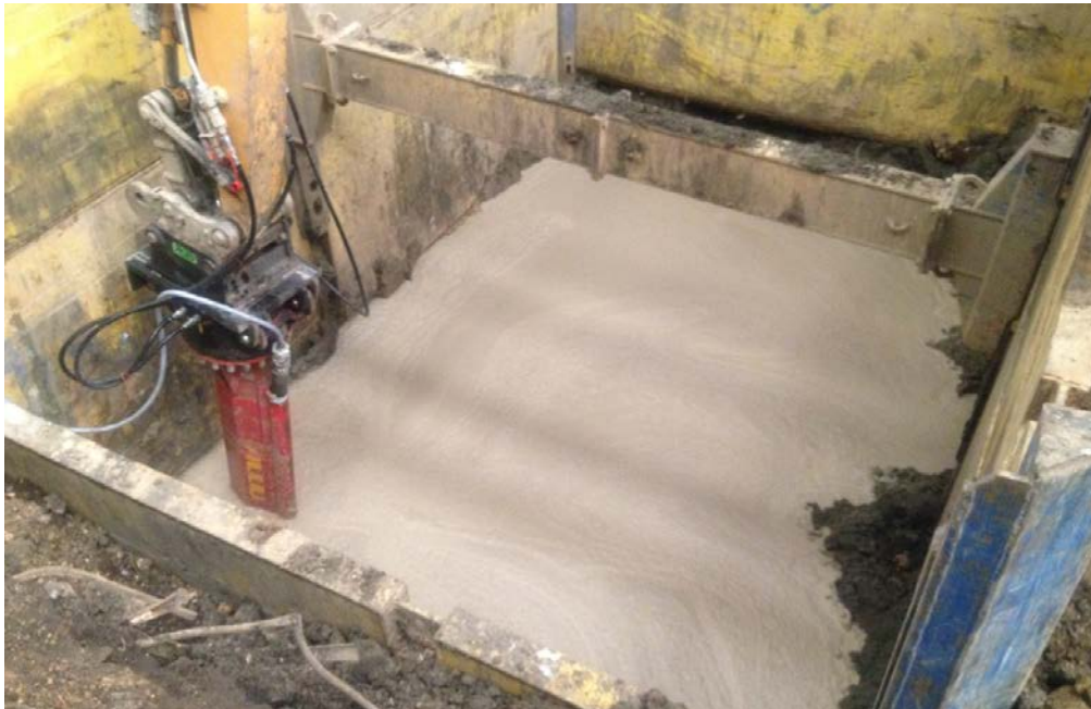
Photo 11. Fosse 2 : traitement du fond de fouille par malaxage (soil-mixing)
