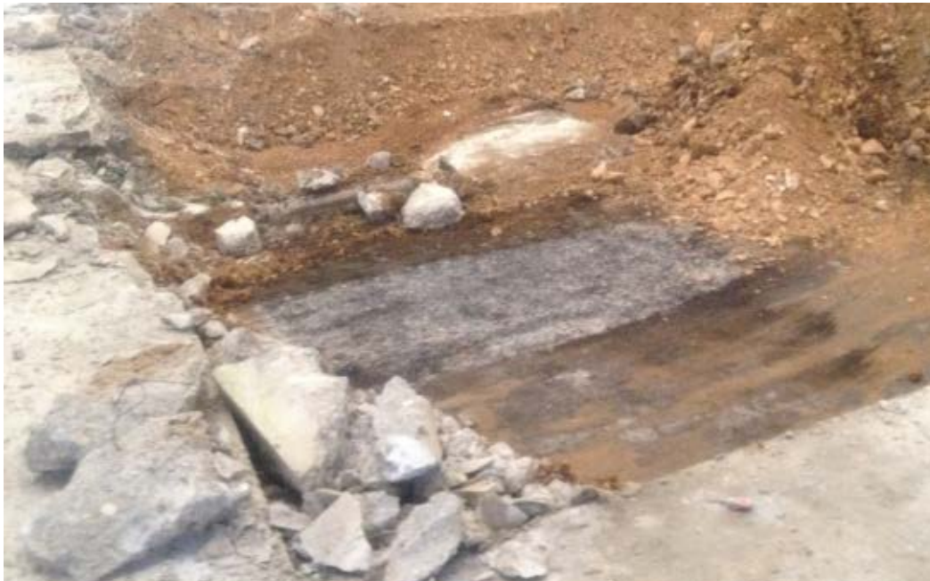
Photo 3. Excavation de la fosse 1: présence d'enrobé à 0,4 m de profondeur
